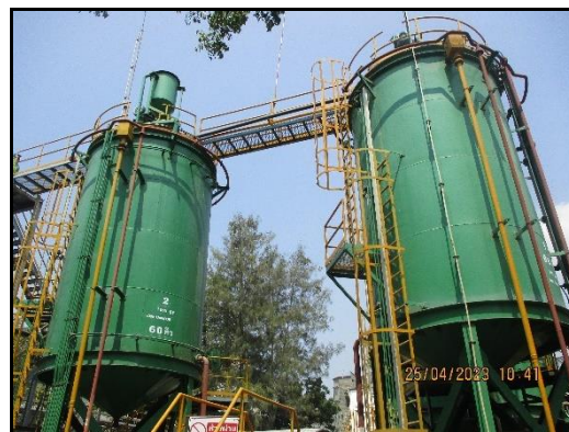
ภาพที่ 2.66 หัวฉีด และระบบหัวกระจายน้ำ-โฟม บริเวณถังเก็บของเสียที่เป็นของเหลว
