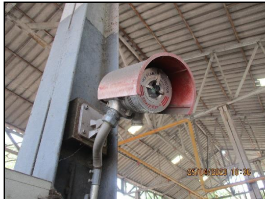
ภาพที่ 2.65 Sensor จับความร้อนบริเวณถังเก็บของเสียที่เป็นของเหลว
