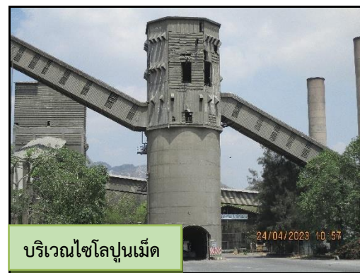
ภาพที่ 2.3 สายพานลำเลียงระบบปิดบริเวณต่างๆ ภายในโรงงาน
