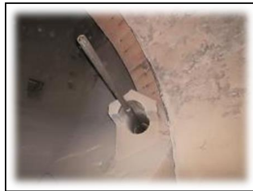
ภาพที่ 2.15 การติดตั้ง Kiln inlet gas analyzer
