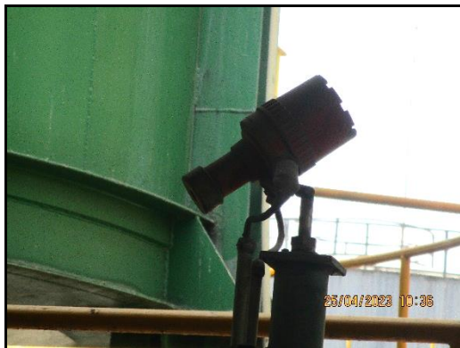
ภาพที่ 2.65 Sensor จับความร้อนบริเวณถังเก็บของเสียที่เป็นของเหลว
