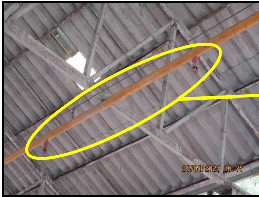
ภาพที่ 2.66 (ต่อ) หัวฉีด และระบบหัวกระจายน้ำ-โฟม บริเวณถังเก็บของเสียที่เป็นของเหลว
