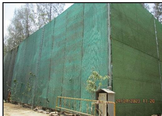
ภาพที่ 2.79 ระบบป้องกันฝุ่นเชื้อเพลิงชีวมวล
