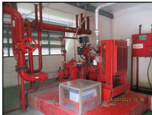
ภาพที่ 2.72 เครื่องสูบน้ำดับเพลิง บริเวณโรงผลิตถุงกระดาช
