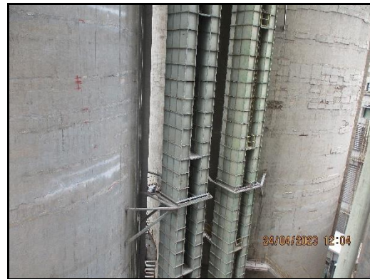
ภาพที่ 2.14 Standby Bucket Elevator
