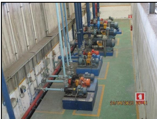
ภาพที่ 2.73 เครื่องสูบน้ำดับเพลิง บริเวณประปา
