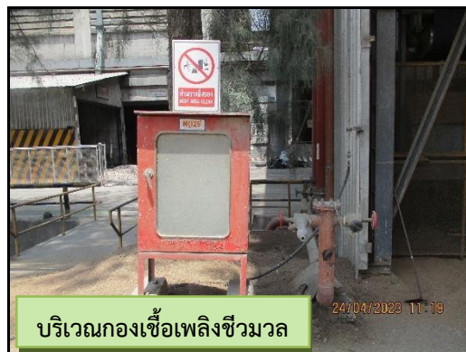
ภาพที่ 2.81 ท่อรับน้ำและสายจ่ายน้ำดับเพลิงภายในโครงการ
