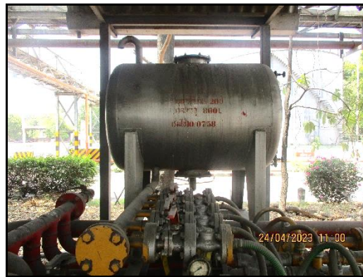
ภาพที่ 2.67 ถังเก็บโฟมบริเวณถังกักเก็บของเสียที่เป็นของเหลว
