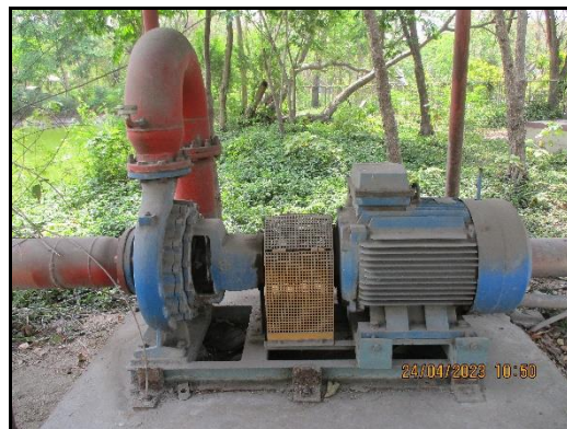
ภาพที่ 2.74 เครื่องสูบน้ำดับเพลิง บริเวณบดซีเมนต์เขาวง
