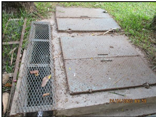
ภาพที่ 2.25 บ่อเกรอะ-บ่อซึม สำหรับบำบัด น้ำทิ้งจากสำนักงาน
