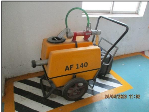
ภาพที่ 2.69 ระบบดับเพลิงด้วยโฟม แบบเคลื่อนย้าย
