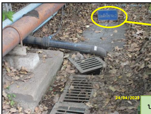
ภาพที่ 2.27 ตะแกรงดักขยะและบ่อดักไขมันบริเวณถึงกักเก็บของเสียที่เป็นของเหลว
