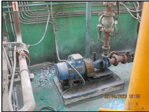
ภาพที่ 2.28 ปัมป์สูบน้ำบริเวณลานถังเก็บของเสีย
