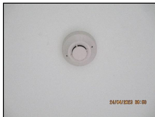
ภาพที่ 2.82 สัญญาณเตือนภัย และเครื่องดับจับควัน (Smoke Detector) บริเวณอาคาร CCR
