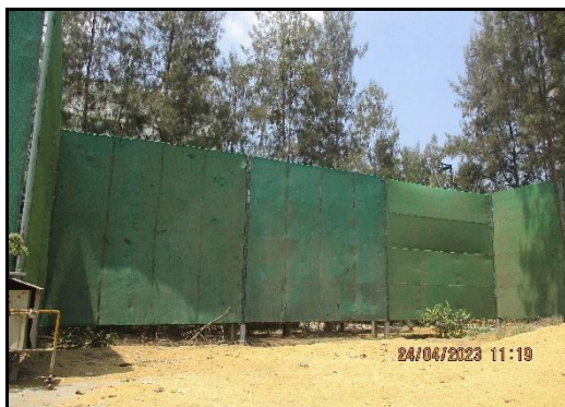
ภาพที่ 2.79 ระบบป้องกันฝุ่นเชื้อเพลิงชีวมวล
